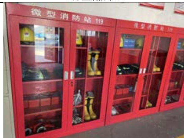
厂区微型消防站
